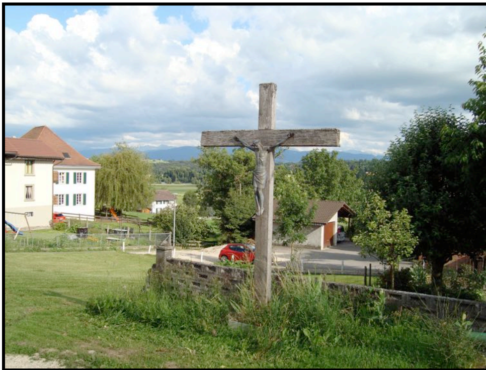
A Noréaz, la croix à l'emplacement de la chapelle démolie
