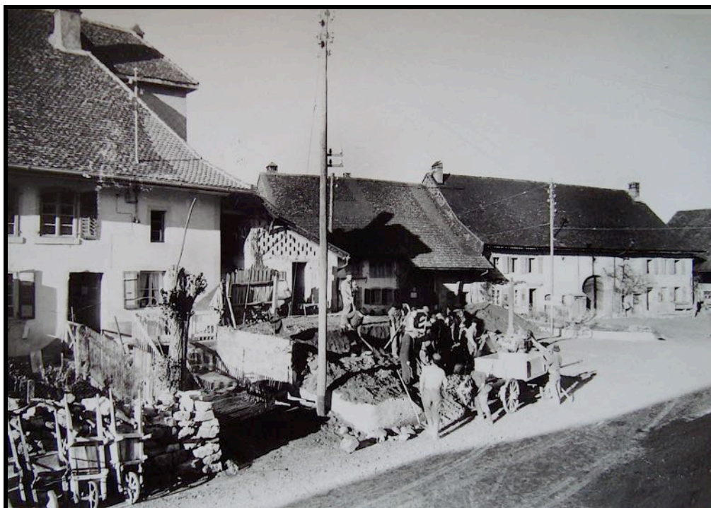
En 1951, démolition du four communal avec les moyens de l'époque.
