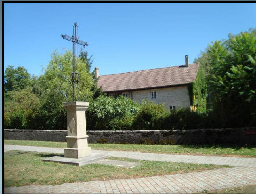
L'école ménagère avec, à l'étage, la salle paroissiale.
